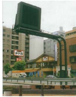
写真3 大阪府内：ダブルオーバーハング柱
