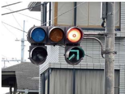
写真6 京都、嵐山に設置されたLED矢印灯器：1995年製
