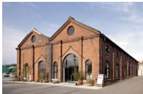
写真1 信号電材本社事務所(国登録有形文化財)
